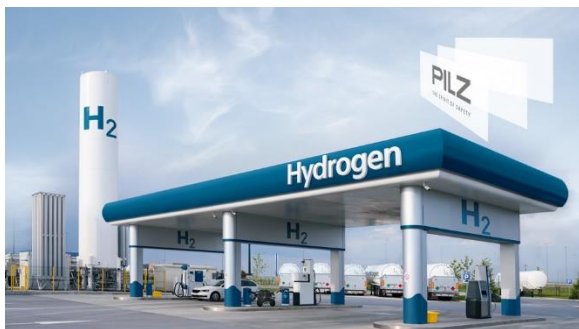
圖片說明： 加氫站的一般安全功能包含氫氣洩漏、火焰與煙霧偵測，以及溫度與壓力監控。 版權所有： © iStock.com/Scharfsinn86, © Pilz GmbH & Co. KG
